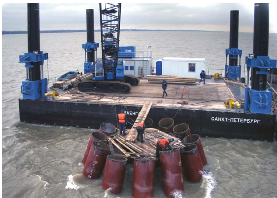
Монтаж основания знака
