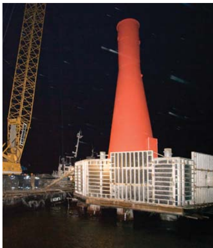
Монтаж створного знака
