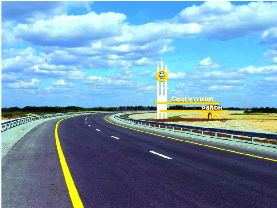
Участок автомобильной дороги, входящей в меридиональный автодорожный коридор Тюмень – Сургут – Надым – Салехард
