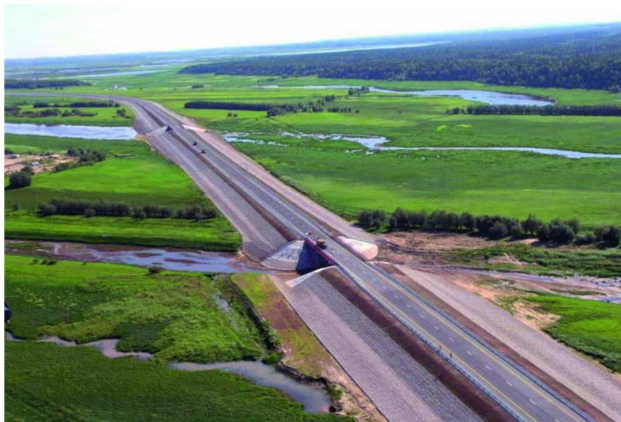
Автомобильная дорога Нефтеюганск — Сургут, входящая в состав меридионального автодорожного коридора Тюмень — Сургут — Надым — Салехард
