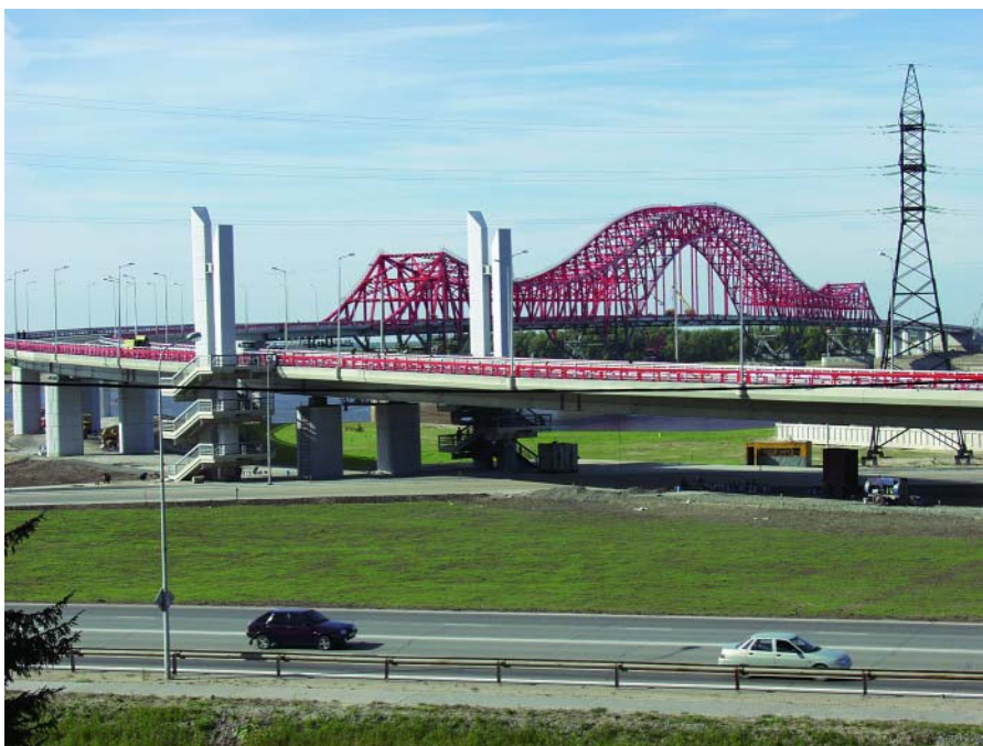
Мостовой переход через р. Иртыш (г. Ханты-Мансийск) на автомобильной дороге, входящей в автодорожный коридор Пермь — Ивдель — Ханты-Мансийск — Сургут — Нижневартовск — Томск
