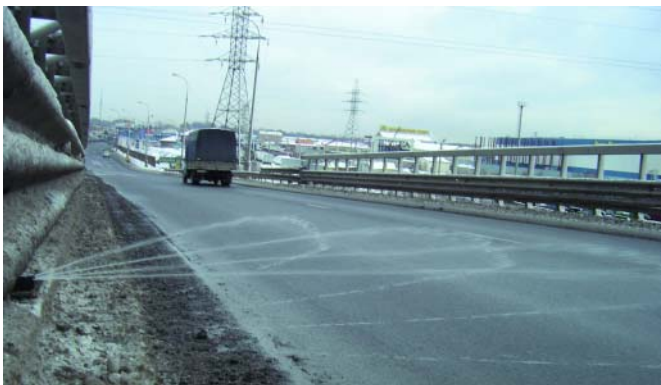
Рис. 2. Разбрызгивающие элементы-головки в действии (эстакада съезда с МКАД на Горьковское шоссе в сторону области, Москва)
