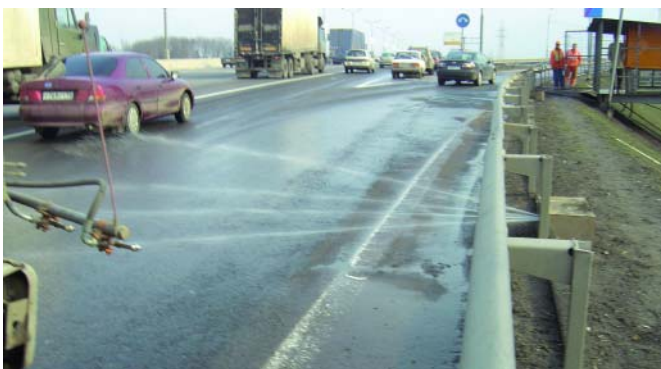
Рис. 3. Работа противогололедной установки на МКАД (обработка правой полосы и съезда на Старокалужское шоссе)
