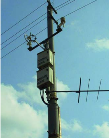
Рис. 4. Контрольно-измерительный блок, смонтированный на мачте светового освещения (автоматическая противогололедная установка на мостовом переходе у пос. Хрипань, Московская область)
