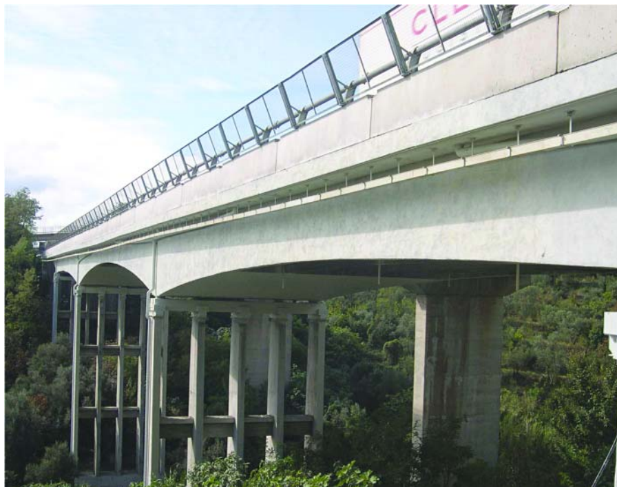
Комплексное восстановление транспортных сооружений
