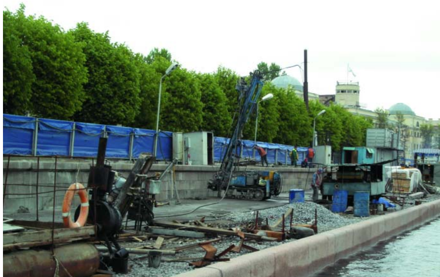
Укрепление подпорной стены набережной Лейтенанта Шмидта
