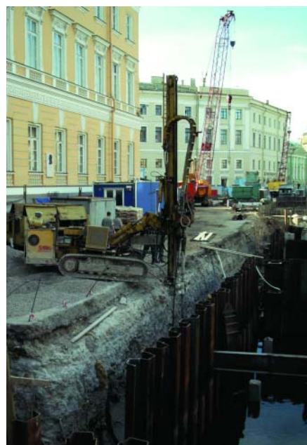
Певческий мост. Устройство свай усиления Titan
