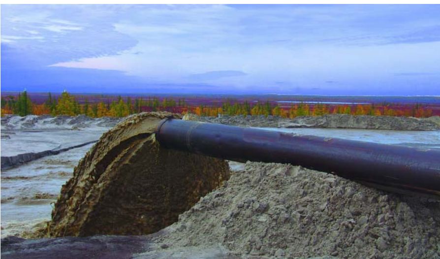
Намыв резерва грунта на севере Тюменской области
