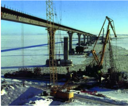
Рис. 7. Пролетное строение с ортогольной плитой проезжей части моста через р. Каму у с. Сорочьи Горы
