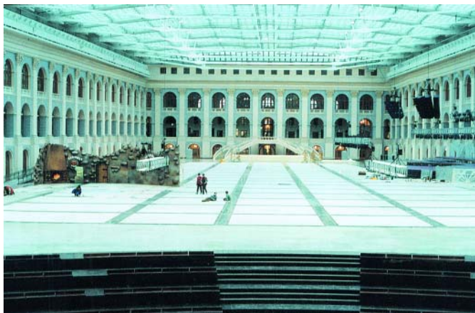
Элементы внутренней отделки атриума Старого Гостиного двора
