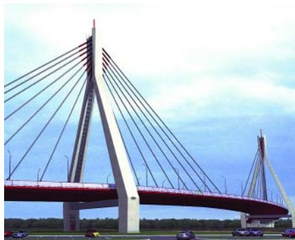
Путепровод в створе пр. Александровской Фермы в С.-Петербурге
