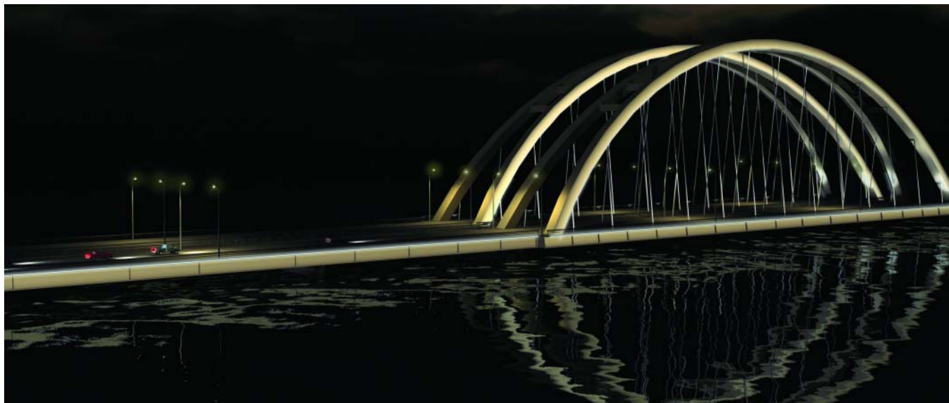
Мост через р. Большая Охта в С.-Петербурге
