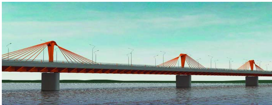
Южный мост через р. Даугава в Риге
