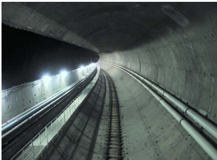
Сборная водонепроницаемая железобетонная обделка тоннелей конструкции ОАО ЦНИИС и ее применение при строительстве Лефортовского тоннеля
