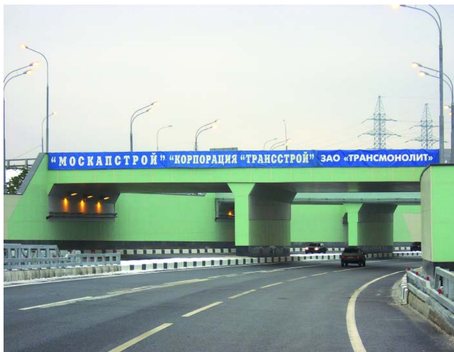
Рис. 1. Путепровод тоннельного типа на ПК 67
