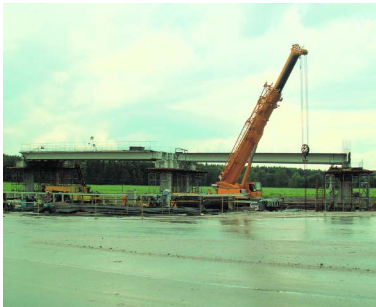
Рис. 2. Строительство подходов разворотной эстакады
