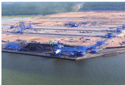
Строительство угольного терминала в МТП Усть-Луга
