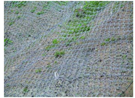
Рис. 6. Белым цветом выделены монтажные анкера
