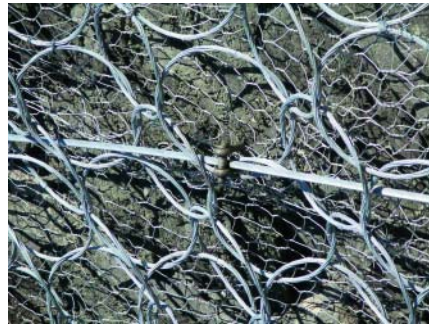
Рис. 5. Крепление кольчужной сети к прижимному канату скобами
