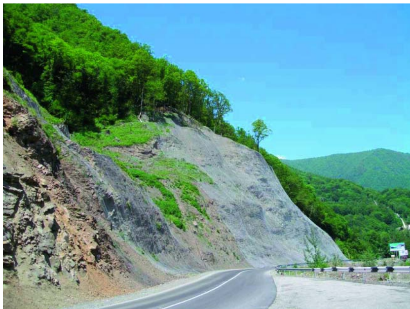
Рис. 2. Защита скально-обвальных откосов сетчатыми покрытиями
