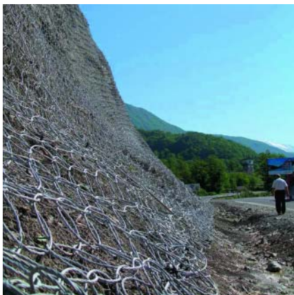
Рис. 3. Общий вид скально-обвального откоса, покрытого кольчужной сетью
