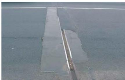
**Рис. 2. Конструкция деформационного шва, разрушенная всего через 3 года эксплуатации (интенсивность 10 тыс. автомобилей в сутки по полосе)**
