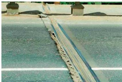
**Рис. 1. Конструкция деформационного шва, разрушенная через 2 года после установки на ремонтируемом мосту (интенсивность 2 тыс. автомобилей в сутки по полосе, в том числе 25% грузовых)**
