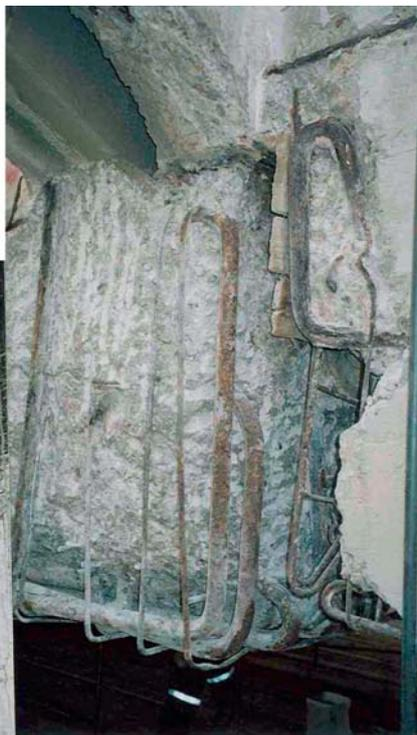
б) Механическая очистка арматуры игольчатым прибором. Обработка металла и подготовка конструкций к бетонированию
