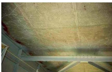
**Рис. 3. Трещины в плите построенного сталежелезобетонного пролетного строения возникли из-за неправильной технологии раскручивания**
