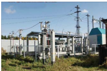
Рис. 6. Устройства продольной компенсации
