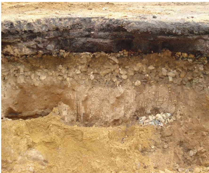
Рис. 1. Разрез конструкции дорожной одежды автомобильной дороги
