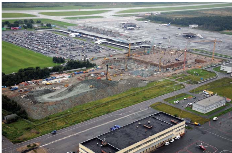
Рис. 3. Строительная площадка нового терминала аэропорта Пулково
