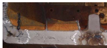
Рис. 1. Литейные дефекты, обнаруженные в изломе наддрессорной балки модели 100.00.001-6 после усталостных испытаний
