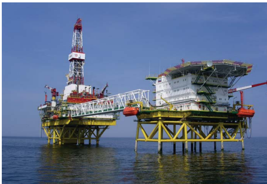
Рис. 1. Морская ледостойкая стационарная платформа (МЛСП) Д-6 на Кравцовском месторождении в Балтийском море
