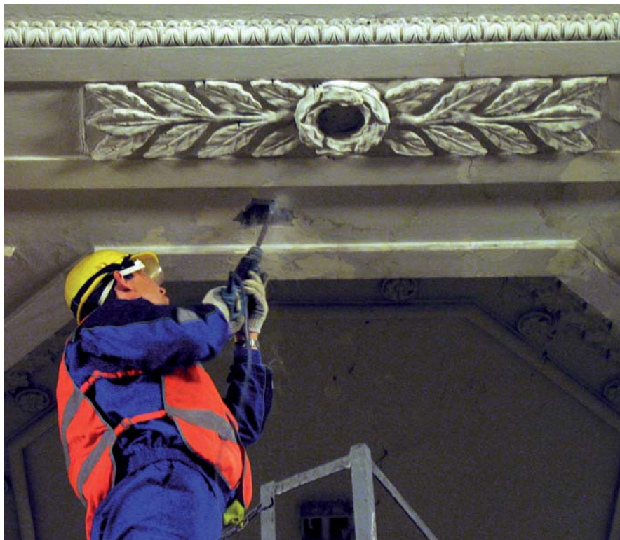
Рис. 7. Обследование конструкций подвесного потолка на станции «Автово»
