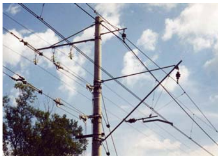
Рис. 1. Контактная сеть КС-160
