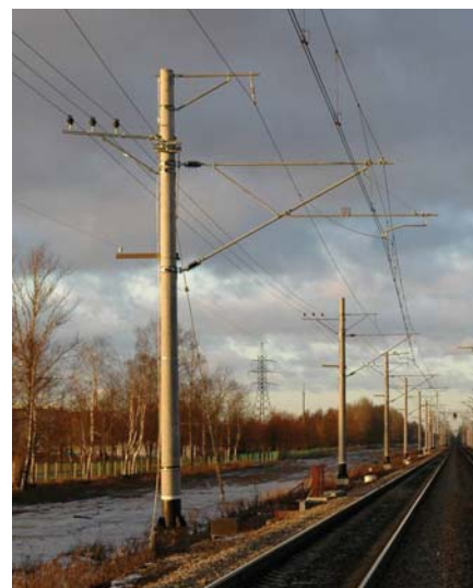
Рис. 2. Контактная сеть КС-200
