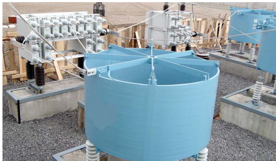
Рис. 8. Общий вид фильтрокомпенсирующей установки для тяговых подстанций переменного тока
