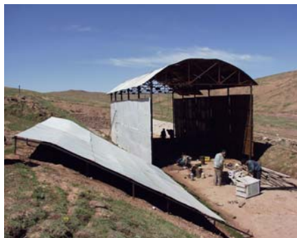
Рис. 1. Сооружение моделей солнцезащитного навеса на экспериментальном полигоне СЗФ, июль 2000 г. Фото Чжан Лусина
