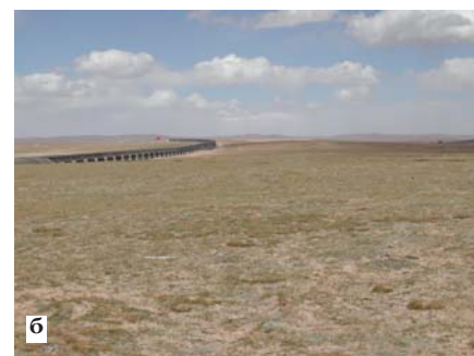
Рис. 4. Экспериментальные конструкции Цинхай-Тибетской ж. д. на участках вечномерзлых грунтов: а — с термосифонами, август 2006 г.; б — «сухой мост», сентябрь 2004 г.
