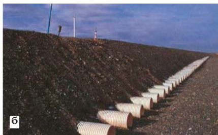
Рис. 3. Поперечные вентилируемые трубы в основании земляного полотна Цинхай-Тибетской ж. д. на участках льдистых грунтов: а — пластиковые, б — железобетонные, автоматически закрывающиеся крышками (фото профессора Нью Фуджина)
