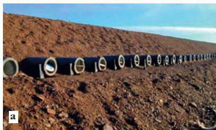
Рис. 3. Поперечные вентилируемые трубы в основании земляного полотна Цинхай-Тибетской ж. д. на участках льдистых грунтов: а — пластиковые, б — железобетонные, автоматически закрывающиеся крышками (фото профессора Нью Фуджина)
