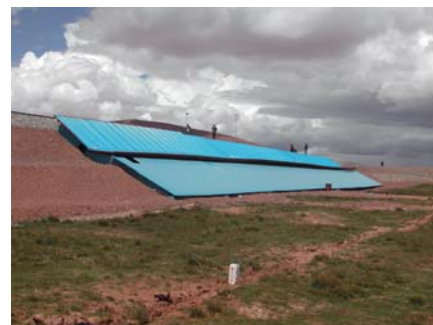
Рис. 2. Солнцезащитные навесы на откосах земляного полотна Цинхай-Тибетской ж. д. на участке льдыстых грунтов в основании, 12 августа 2006 г.
