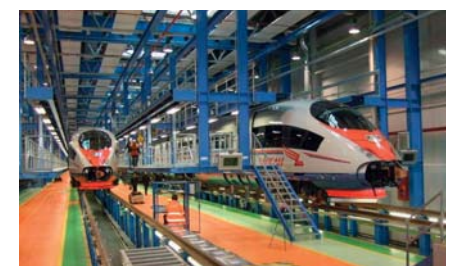
Рис. 10. Моторвагонное депо Санкт-Петербург-Московское
