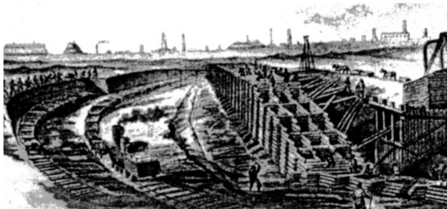
Строительство Морского канала на подходе к Петербургу
