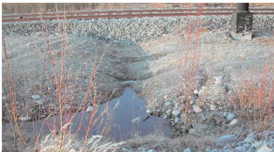
Рис. 4. Засыпка термокарстовых просадок балластом, подъездной путь Чара — Чина, май 2008 г.
