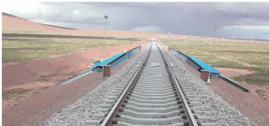
Рис. 6. Солнцезащитные навесы на откосах насыпи Цинхай-Тибетской ж.д., август 2006 г.
