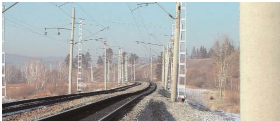
Рис. 1. «Золотой километр» Забайкальской жд. — участок 60-летних деформаций пути, км 6277 — км 6278, ноябрь 2006 г.
