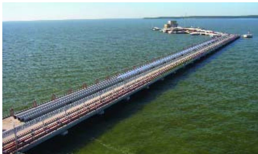
Общий вид эстакады в порту Приморск
