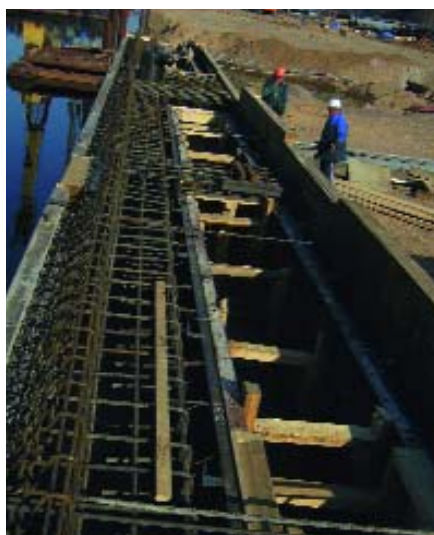
Монтаж верхнего строения причала
