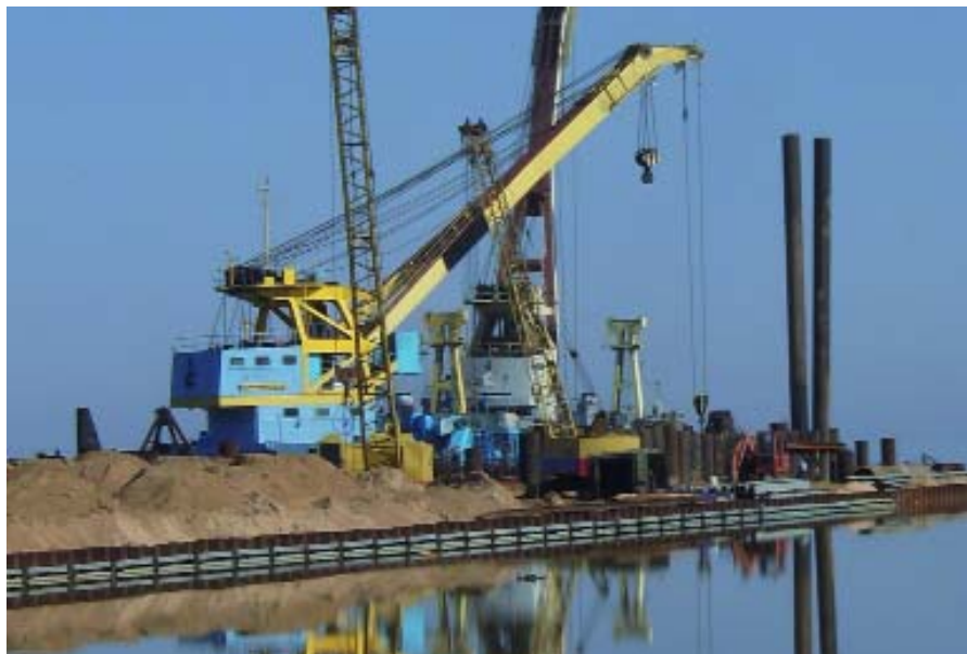
Строительство комплекса наливных грузов В МТП Усть-Луга
