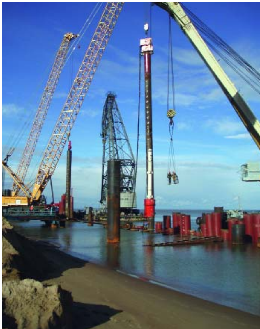
Свайные работы на Балтийском контейнерном терминале
