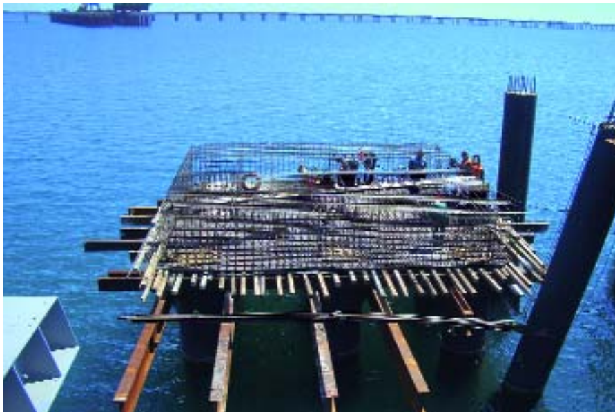
Процесс сооружения верхнего строения отбойного пала
