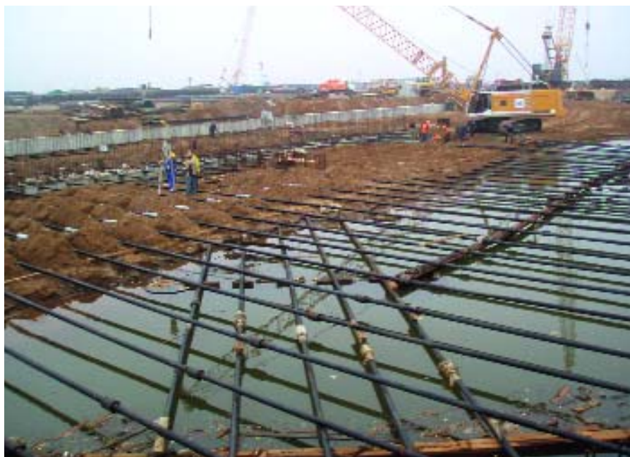
Устройство анкерной системы причалов Балтийского контейнерного терминала
