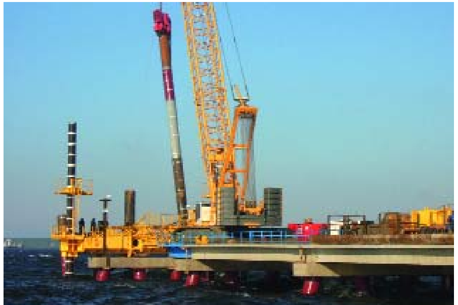
Строительство причальных сооружений комплекса светлых нефтепродуктов в порту Приморск
