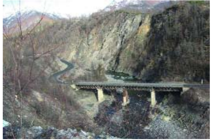
Строить дороги в Якутии намного сложнее, чем в европейской части страны
