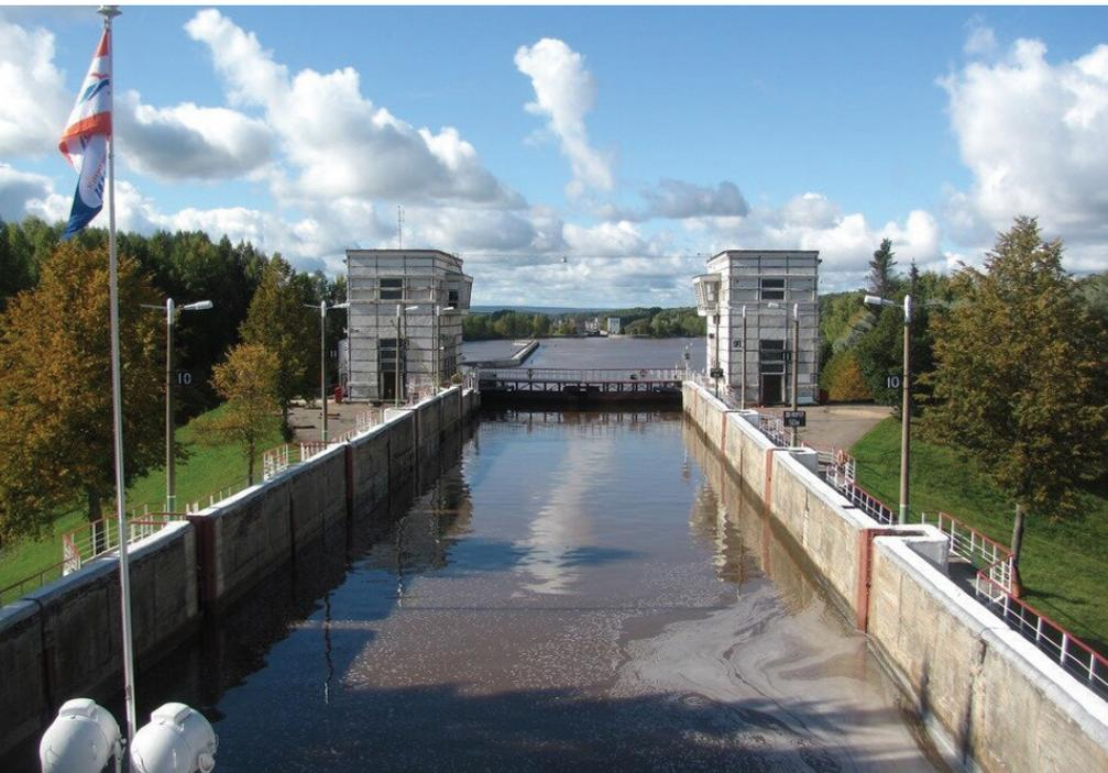
обеспечивали удовлетворительные условия стоянки судов при значительном увеличении времени наполнения. Крупнотоннажным судам, чтобы обеспечить снижение действующих продольных гидродинамических сил, рекомендовано располагаться у нижних голов камер. Эти рекомендации предназначены для обеспечения безопасного пропуска крупнотоннажных судов через шлюзы КиМ, и при условии, что высота подъема ворот будет снижена с 2,2 до 1,2–1,3 м.
