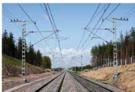
Рис. 1. Контактная подвеска на участке Торбино – Боровенка линии скоростного сообщения Санкт-Петербург – Москва
