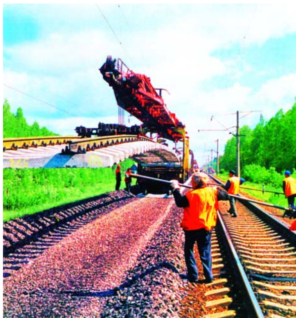
Укладка современной конструкции верхнего строения пути
