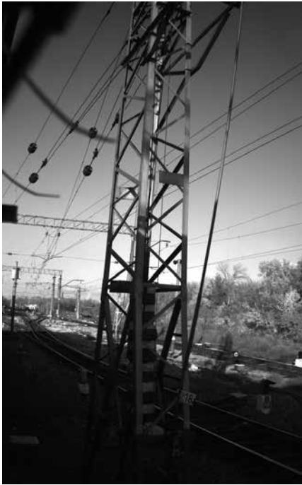
Рис. 3. Состояние компенсирующих устройств: изображение с камеры контроля
