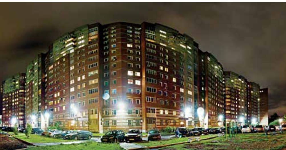
Освещение внутридворовых территорий светодиодными светильниками «УСС -36» и «УСС -70», г. Пермь
