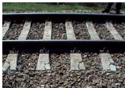
Рис. 5. Повреждения шпал
