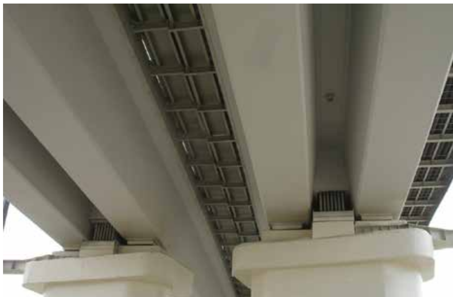
Рис. 6. Стержневые амортизаторы на одной из железнодорожных эстакад в г. Сочи
