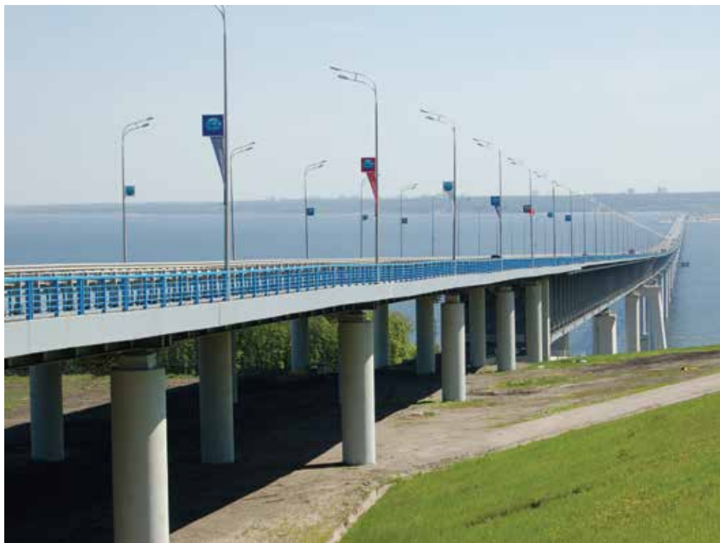
Мостовой переход через р. Волгу, г. Ульяновск. Общая длина – 12 976 м (включая береговые подходы с эстакадами и 6 путепроводами)
