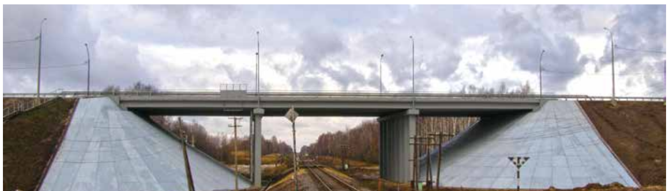
Путепровод с подходами над ж.-д. путями на км 403 трассы М-5 «Урал», Рязанская обл. Протяженность участка — 0,92 км, категория — IV, количество полос — 4, земляные работы — 260 741 м 3 , площадь дорожной одежды — 17 447 м 2
