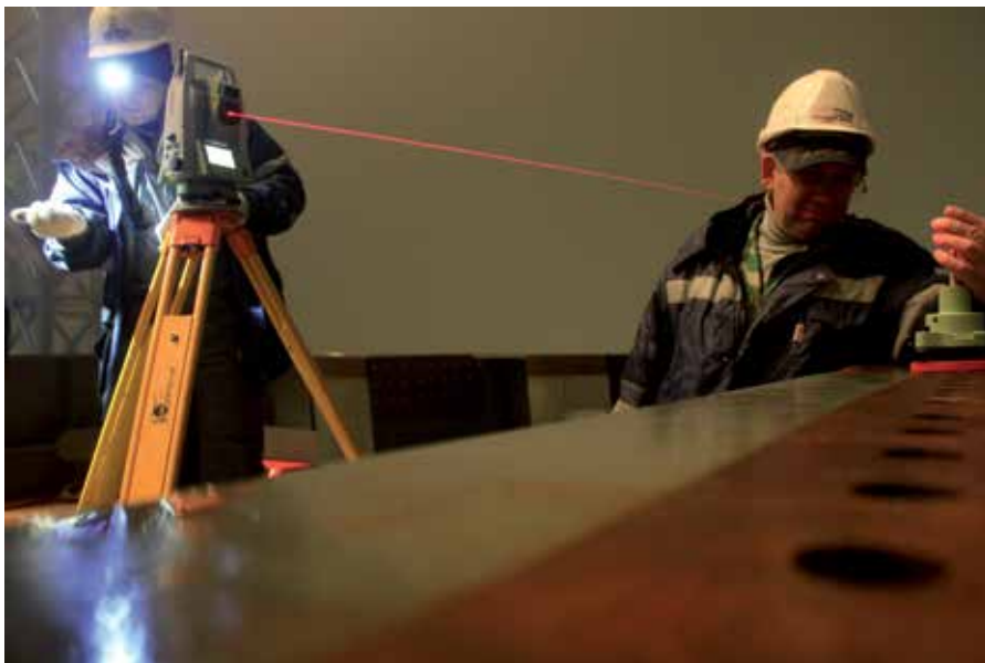
Рис. 7. Обратная засечка на блоке пилона и координирование центра опорной поверхности вантового узла
