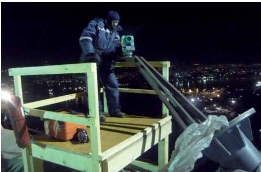
Рис. 8. Определение координат контрольных точек вантового узла на пролете
