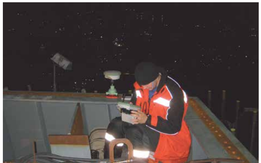
Рис. 6. Определение координат контрольных точек на блоке пилона спутниковой геодезической аппаратурой
