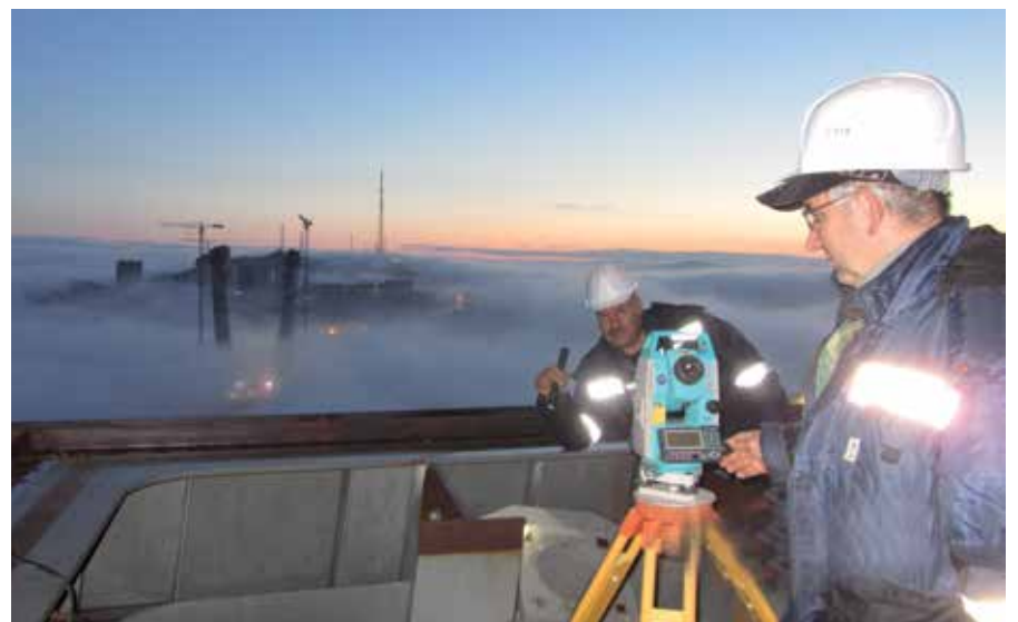
Рис. 5. Вид на строительство пилонов вантового моста
