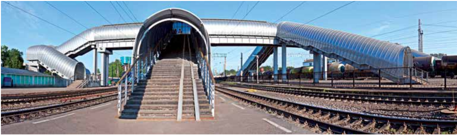
Пешеходный мост на ст. Вологда
