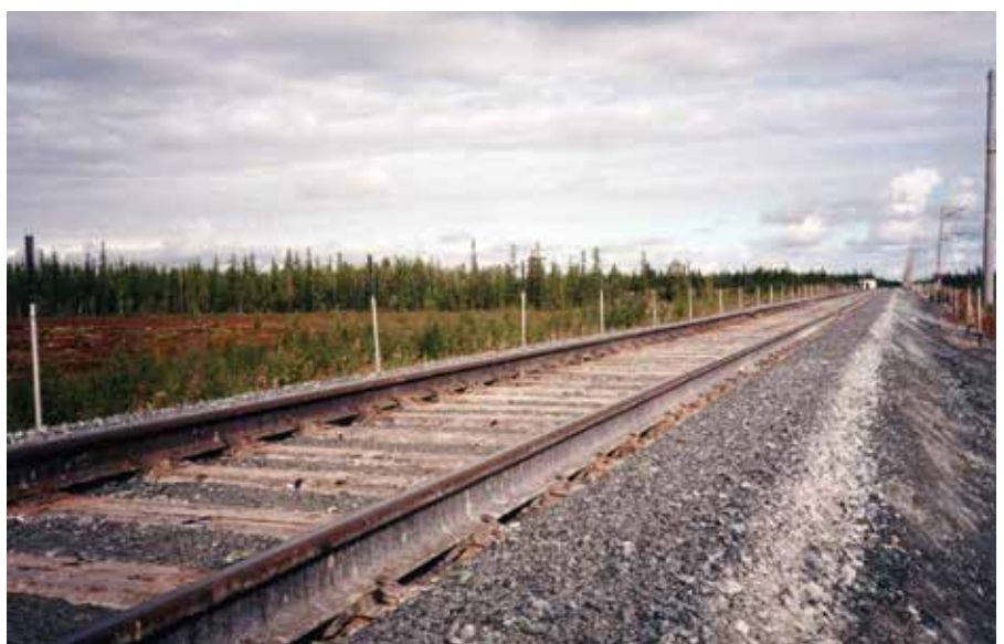
Рис. 5. Участок пути с парожидкостными СОУ
