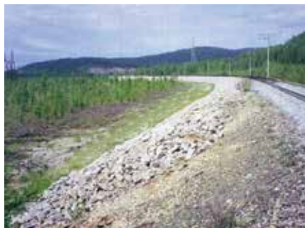
Рис. 3. Охлаждающая каменная наброска на откосах
