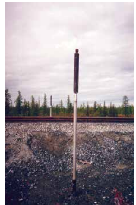
Рис. 4. Парожидкостная сезоннодействующая охлаждающая установка (СОУ)
