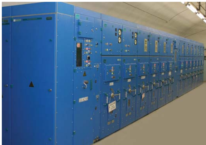
Функциональный блок РУ-825 В на базе ячеек серии КВ
