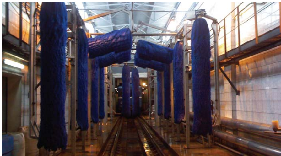
Санкт-Петербург, эксплуатационное депо метрополитена ТЧ-1 «Автово».
