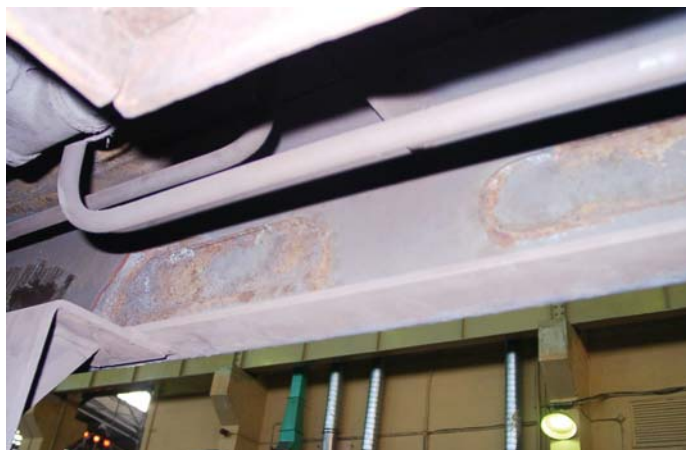
Рис. 2. Коррозия продольной балки рамы вагона
