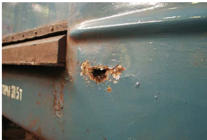
Рис. 1. Сквозная коррозия обшивки концевой стены
