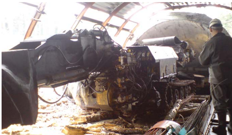
Комбайновая проходка наклонного ствола с поверхности (Междуреченск, Кемеровская обл.)
