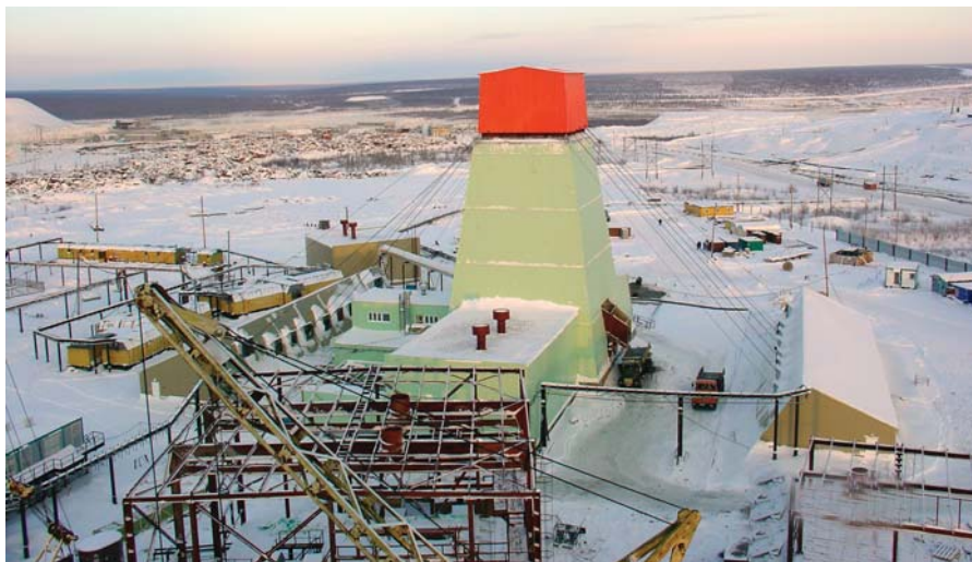
Проходка вертикального ствола и строительство поверхностного комплекса (рудник «Удачный», Якутия)
