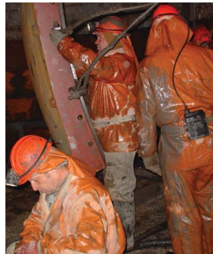
Крепление ствола чугунными твингами (рудник «Мир», Якутия)
