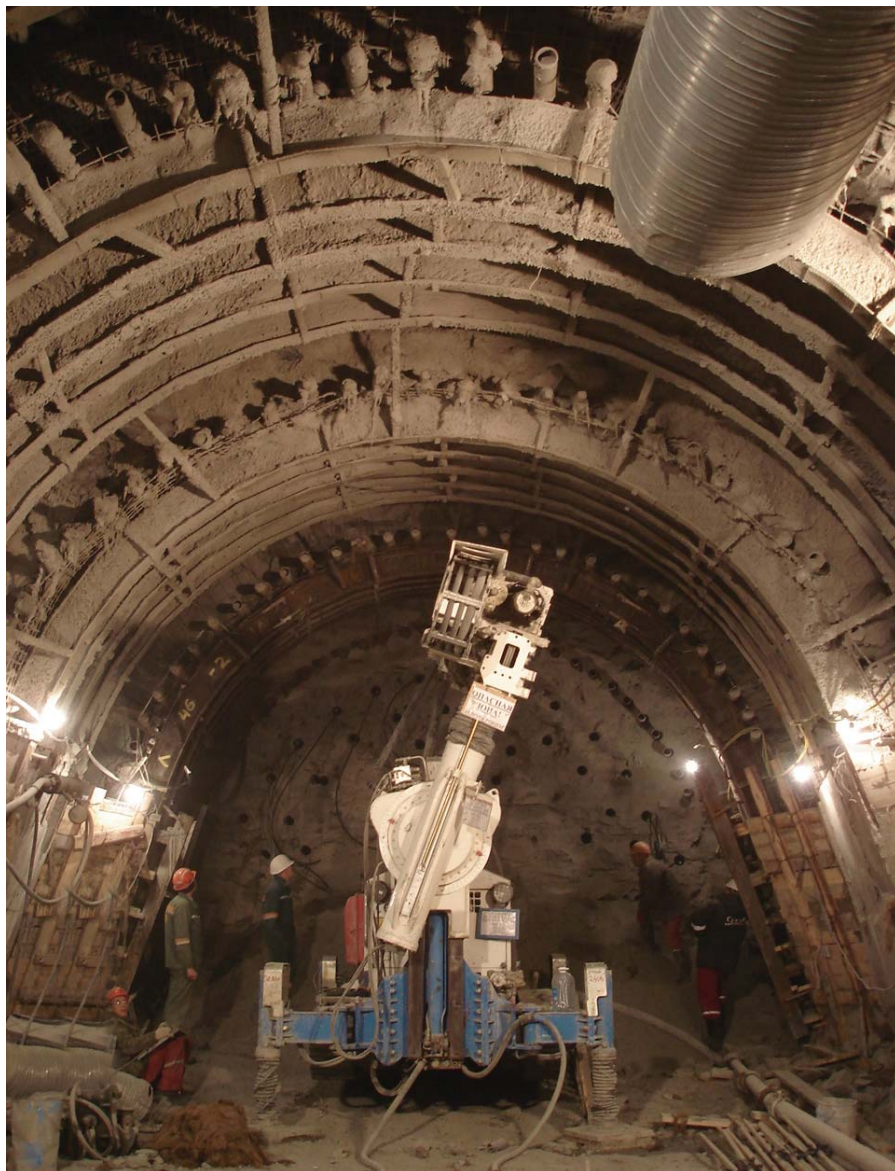
Рис. 4. Устройство опережающего крепления лба забоя из фиброглассовых анкеров
