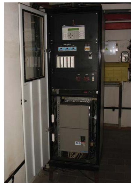
Рис. 4 Система автоматического управления вентилятором
