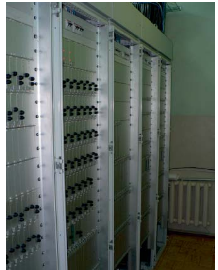
Фото 3. Устройства сопряжения с напольными устройствами
