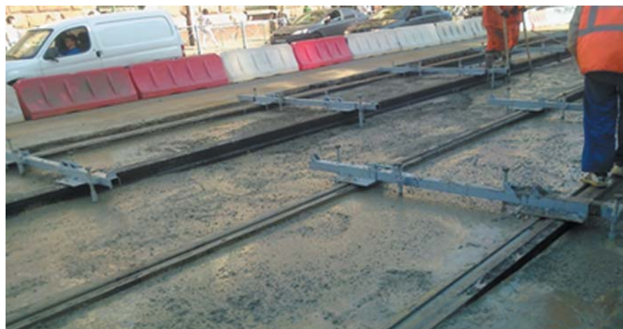
Рис. 3. Строительство трамвайных путей с использованием фибробетонной плиты
