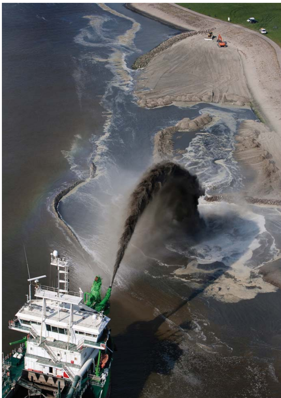
Работы по образованию территории
