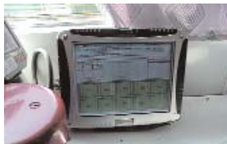
Рис. 4. Монитор бортовой системы мониторинга КОМПАКС-ЭКСПРЕСС-3 в кабине машиниста электропоезда.
