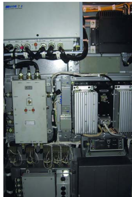
Установка систем безопасности в отдельном шкафу на электровозе ЧС7
